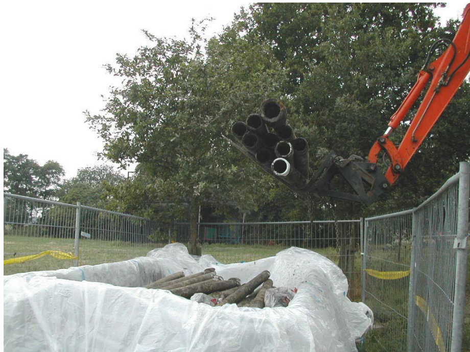
Het verpakken van de uitgenomen AC-buizen voor transport naar de stortplaats.
